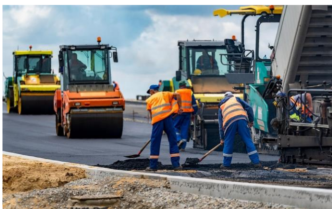
Attēls Nr. 5: Ceļu remontdarbi.
